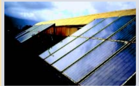
Paneles solares utilizados en la climatización de los invernaderos en El Golfo
