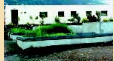
Digestor de metano, Laguna de Plantas Acuáticas y Balsa de Tilapias
